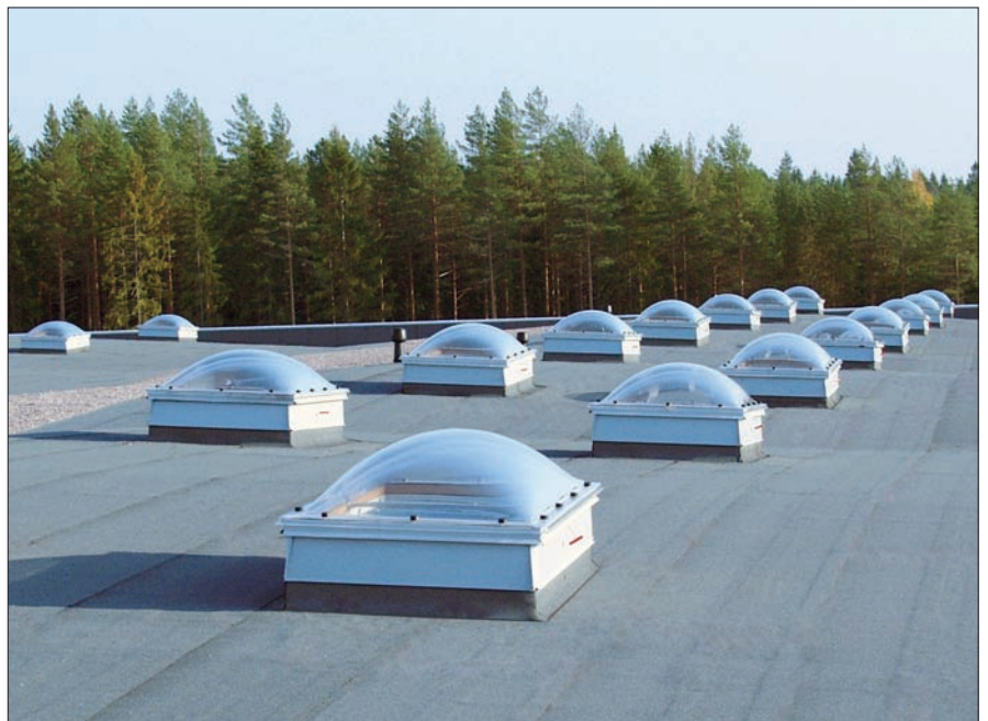
Kuppelkatuseaknad M3N, Hansa Logistics, Hämeenlinna. Kuplid on ühtlasi suitsueemaldusluukideks.
