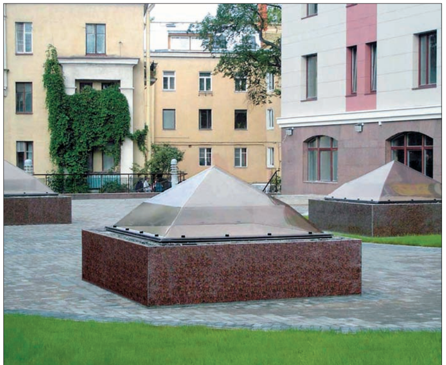
Kuppelkatuseaknad PM1N, korterelamu autoparkla katus-õu, St Peterburg. Veeplekkide asemele on paigaldatud graniitplaadid.
