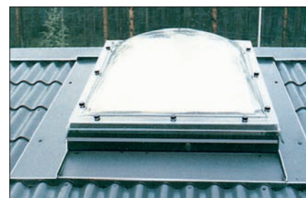
Individuaalelamu kuppelkatuseakna paigaldus lainelisse katusekattesesse.
