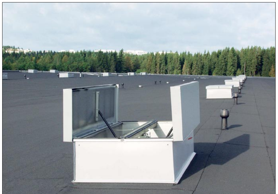
Orivent 52 - suitsueemaldusluugid, BE-Steel. Lahti
